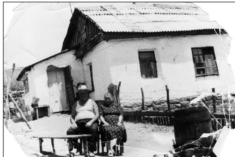
Дом на каменном фундаменте, построенный первыми жителями Береговой, конец 1950-х
